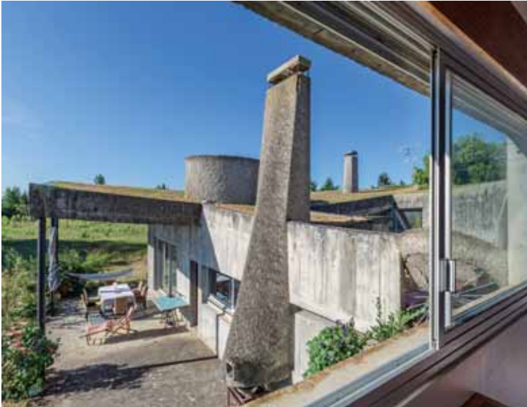
La toiture hélicoïdale plantée de la maison Pradier se développe autour du patio.
